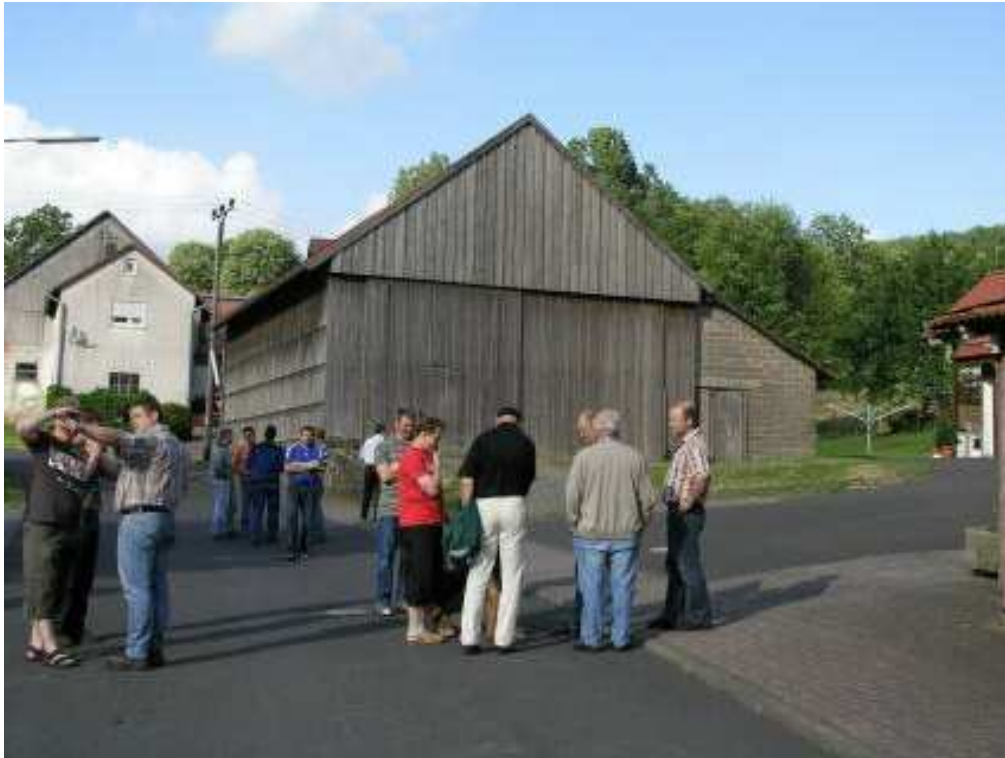
Die ehemalige Dreschhalle
